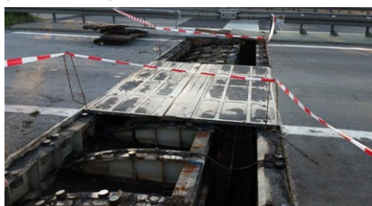
Demontage der alten Mehrplattenübergänge (Rollverschluss)
