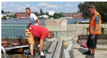
Abschnitt 1 und 2: Einbau der Fugen
