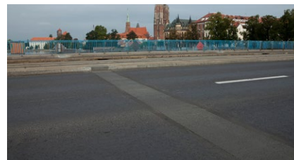
Die fertige Belagsdehnfuge im Fahrbahnbereich
