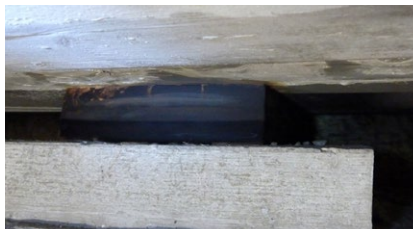
Aufnahme vor Lagerausbau
