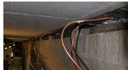
Ausbau der Lager mittels Pressen
