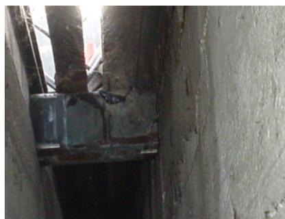
Korrosion von Dehnfugen und insbesondere an ihren beweglichen/gleitenden Verbindungen kann einen negativen Einfluss auf die Funktionstüchtigkeit haben. Häufig führen diese Schäden zu einem vollständigen Austausch, was zu hohen Kosten und starken Auswirkungen auf den Verkehr führt.
