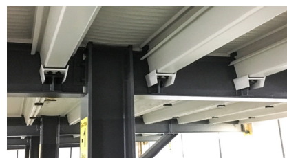
Lager im eingebauten Zustand unter den tragenden Deckenrippen
