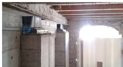
Flonblock eingebaut unter Stahlfachwerk
