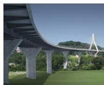
Pont de la Poya (CH)
