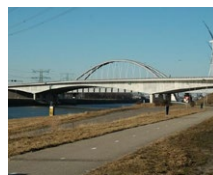
Dintelhaven Bridge (NL)
