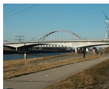
Dintelhaven Bridge (NL)
