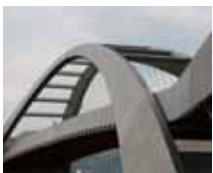
Gleisbogen Brücke (CH)
