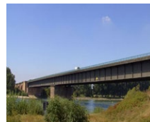
Puente Rhine Frankenthal (DE)
