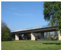
Puente Ohrntal Öhringen (DE)
