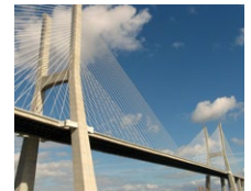
Puente Vasco da Gama (PT)
