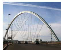
Puente Ramstore (KZ)
