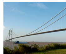
Run Yang Bridge (CN)
