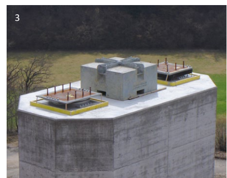
1 Construcción de un apoyo TE con guías externas 2 Apoyo TA con escala externa 3 Apoyos TA y TF con placas de anclaje
