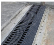
Juntas dentadas deslizantes
