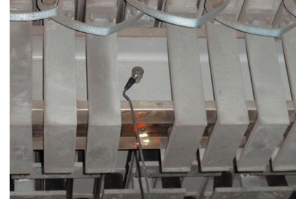
Sensor de vibraciones en junta de dilatación
