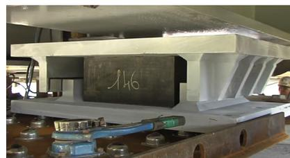
Apoyo LRB (multidireccional) instalado, que permite todos los movimientos.
