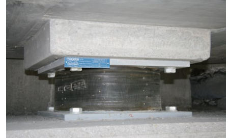
Aisladores de caucho de alta amortiguación
