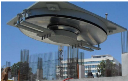
Aisladores de fricción de superficie curva
