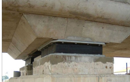
Aisladores de caucho con núcleo de plomo
