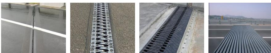
Juntas unicelulares    Juntas dentadas en voladizo    Juntas dentadas deslizantes    Juntas modulares
