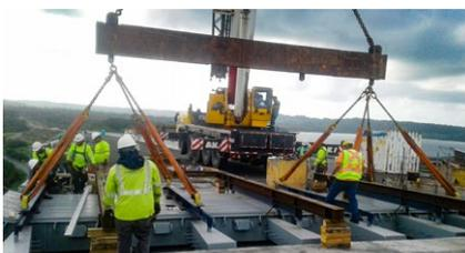
Apoyos laterales con ROBO®SLIDE y placas ajustables para instalarse entre torres y tablero
