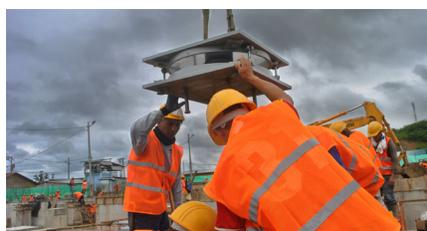
Posicionamiento y nivelación de un aislador sísmico RESTON®PENDULUM
