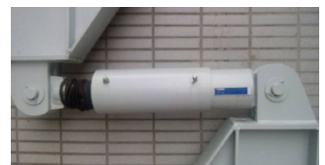
Vista cercana de un amortiguador RESTON®SA, tal como está instalado
