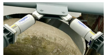
Vista de una sección de arriostamiento reequipado, con dos amortiguadores RESTON®SA
