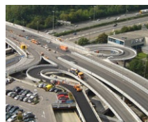
Pont Glattzentrum (CH)
