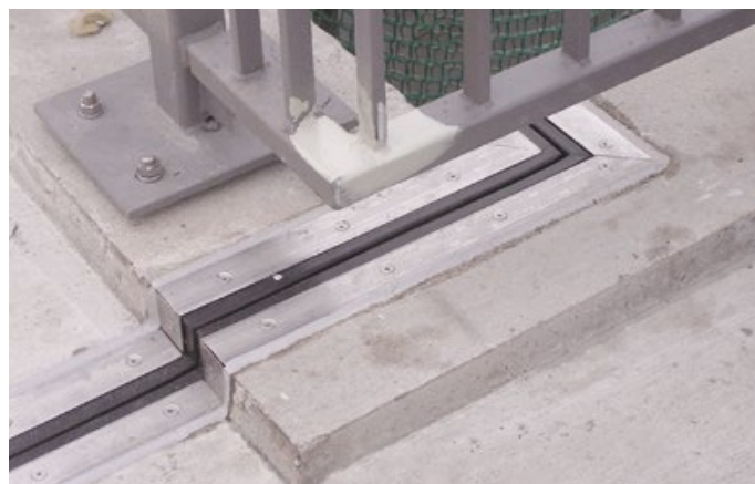
Rénovation de pont à Eilenburg
