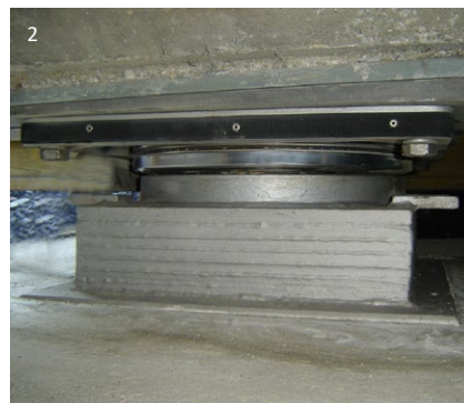
1 Appui KE avec jupe de protection et indicateur de mouvement, prêt pour l'installation
