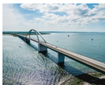
Pont Irtysh River (KZ)
