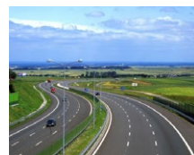
Autostrada Transilvania (RO)
