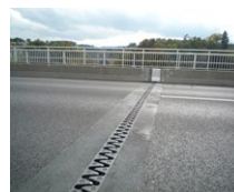
Viaduct de Fürstenland, CH
