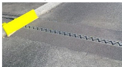
Un joint de dilatation TENSA®CRETE RE-LS100 réduisant le bruit causé par le trafic
