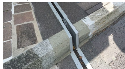
Détail adaption sur le trottoir
