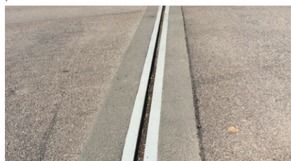
Un joint de dilatation TENSA®CRETE RE-80, installé et permettant un mouvement de 80 mm
