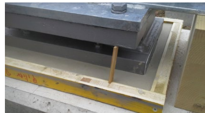
Un appui néoprène RESTON®POT pendant l'installation
