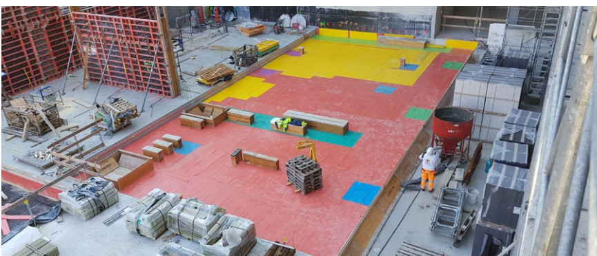
Exemple d'utilisation d'isolation contre les vibrations très efficaces dans un immeuble résidentiel de luxe «Lakeview Residenz» à Vitznau, Suisse
