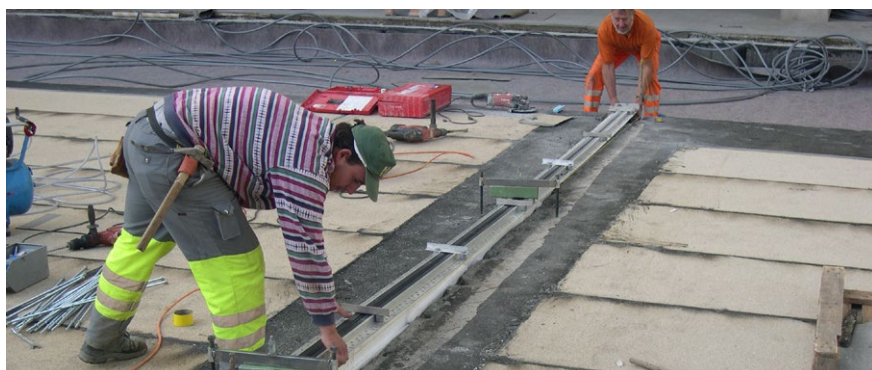
Equipement du parking de la gare de Winterthur (Suisse) avec joints étanches en acier
