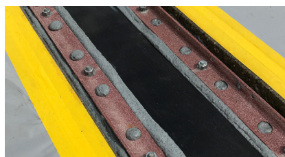
Montage du joint avec les inserts de montage
