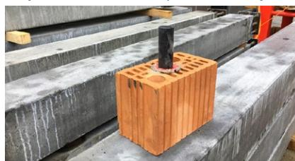
Goujon avec brique intégrée dans la maçonnerie avant le bétonnage
