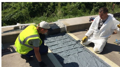
A TENSA®POLYFLEX ADVANCED PU burkolati dilatáció kiöntésre kerül
