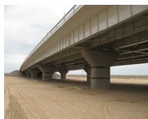
Awaza híd (TM)
