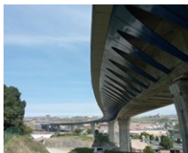
Trapagan viadukt (ES)
