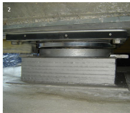
1 KE saru, rajta a porvédő kötény és a mozgásjelző, beépítésre készen
