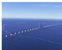
Øresund híd (DK/SE)
