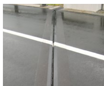
Egytömítőprofilos dilatáció
