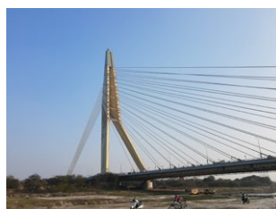
Wazirabad híd, India
