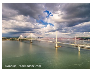
Queensferry híd, UK
