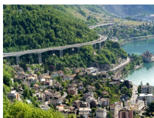
Viaduct de Chillon, Svájc
