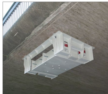
TMD, amelynek sajátfrekvenciája 4,3 Hz és 3,5 t tömegű, egy hídra szerelt, Kiel, Németország
