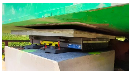
Beépített RESTON®SPHERICAL hídsaru elmozdulás mérő skálával
