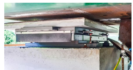
A beépített hídsaruk egyike közelről
