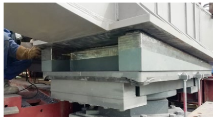
Az egyik RESTON®SPHERICAL saru beépítés közben
