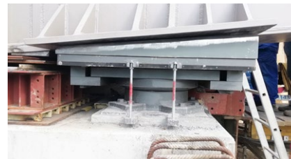
Egy RESTON®SPHERICAL hídsaru beszerelés után
