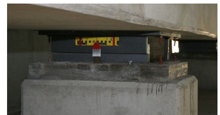
Beépített RESTON®SPHERICAL KF típusú saru
