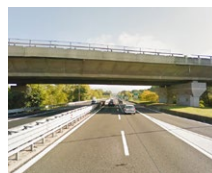
Val Freghizia Bridge (IT)
