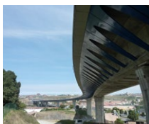
Viaducto de Trapaganar (스페인)
