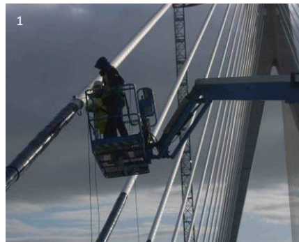
1 Instalación de sensores en un puente atirantado
