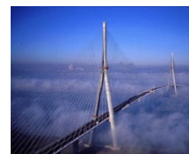
Pont de Normandie (FR)
